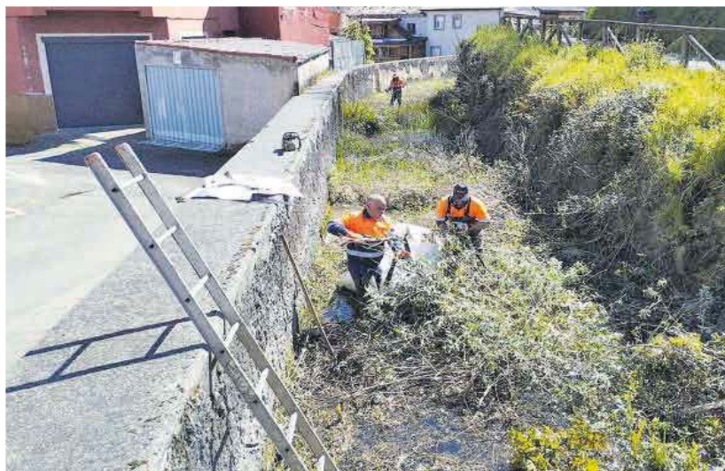
Operarios trabajando en la limpieza del río Triana, ayer, a la altura de Sama. | M. A. G.
