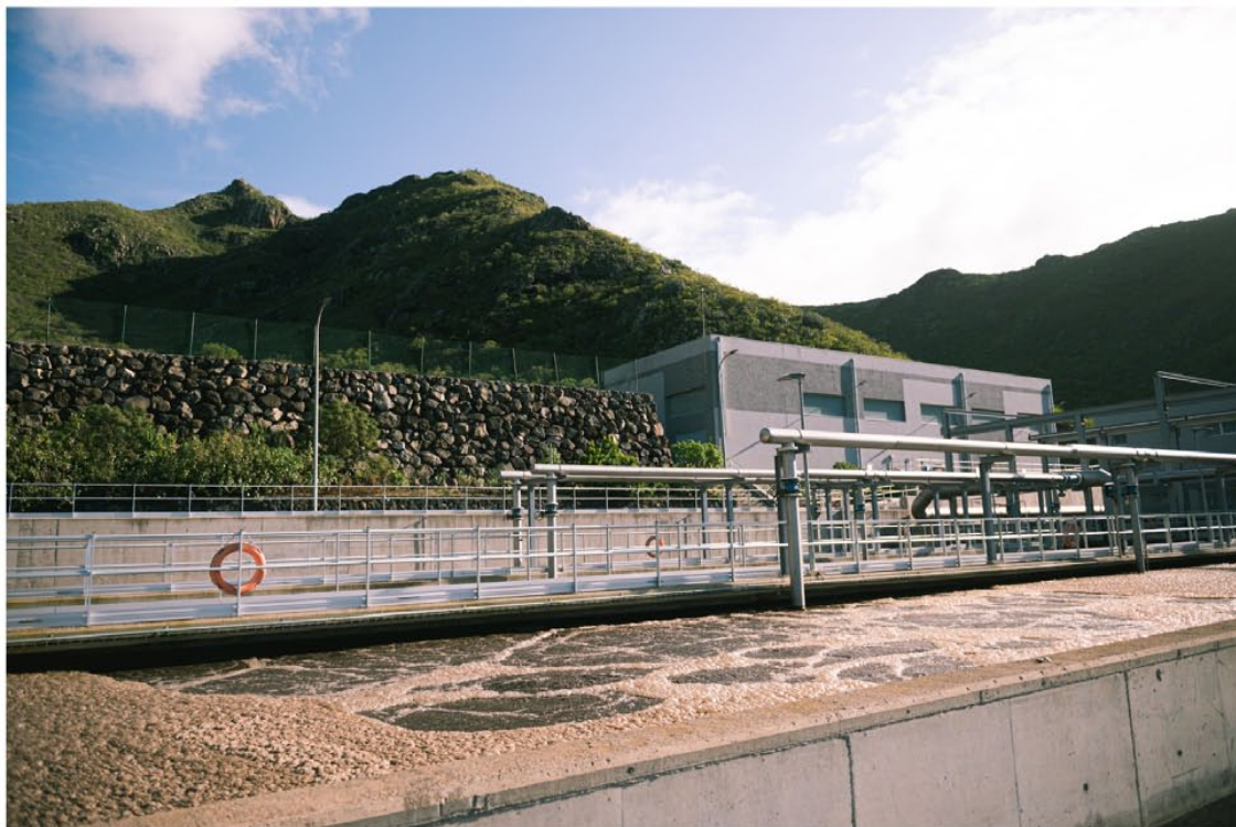
Depuradora de Valle de Guerra, situada en el norte de Tenerife
